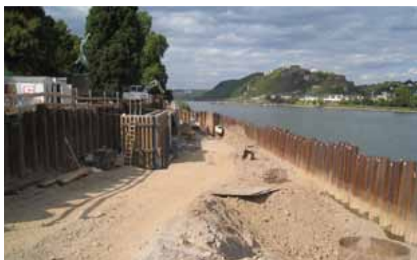
Baumaßnahme Rheinufer in Koblenz
